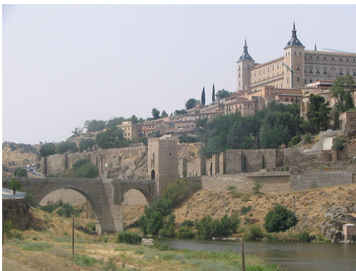
Toledo Puente Alcantara
